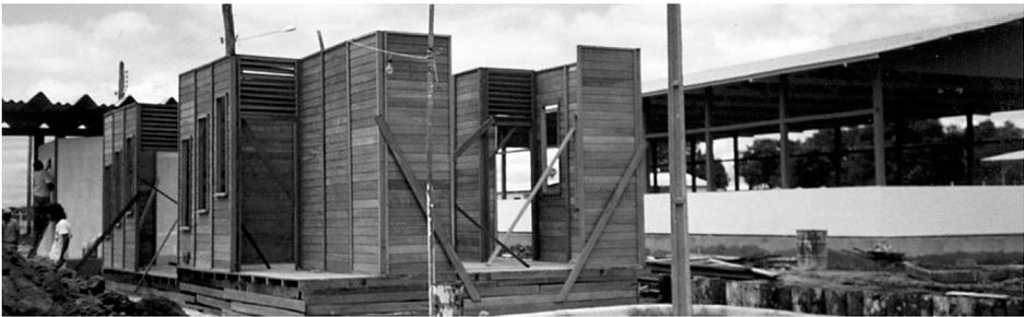
Figura 14 – Habitação em painéis pré-fabricados e modulares de madeira
