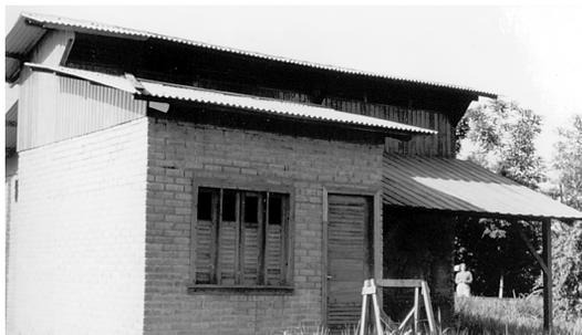
Figura 19 – Protótipo de solo-cimento
