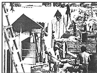
Etapa: Construção Conteúdo: Vista Geral Mutirantes terminando a montagem das casas.
