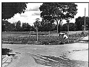
Etapa: Moradia(s) ocupada(s) Conteúdo: Mobiliário Urbano Vista do campo de futebol, dentro do conjunto.
