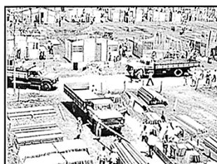
Etapa: Construção Conteúdo: Canteiro de Obra em Atividade Canteiro de obra em atividade.
