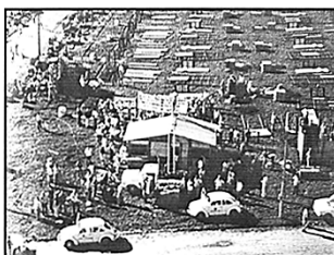
Etapa: Construção Conteúdo: Canteiro de Obra em Atividade Mutirantes chegando ao conjunto.
