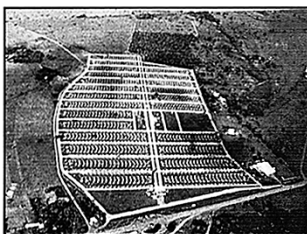
Etapa: Obra pronta Conteúdo: Vista Geral do Conjunto Vista aérea do conjunto.
