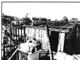
Etapa: Local Moradia Anterior Conteúdo: Área ocupada por favela, Habitações Fechamento da cobertura nas antigas casas.
