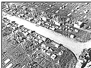
Etapa: Construção Conteúdo: Implantação do Canteiro de Obras Preparação do canteiro de obras.
