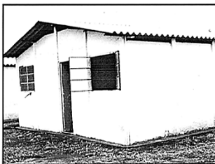
Etapa: Obra pronta Conteúdo: Unidade Habitacional Externa Vista da unidade pronta.
