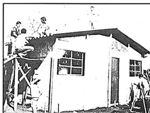
Etapa: Construção Conteúdo: Cobertura Mutirantes terminando a cobertura das casas
