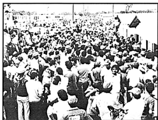
Etapa: Obra pronta Conteúdo: Vista Externa das Moradias Mutirantes reunidos ao final das construções.
