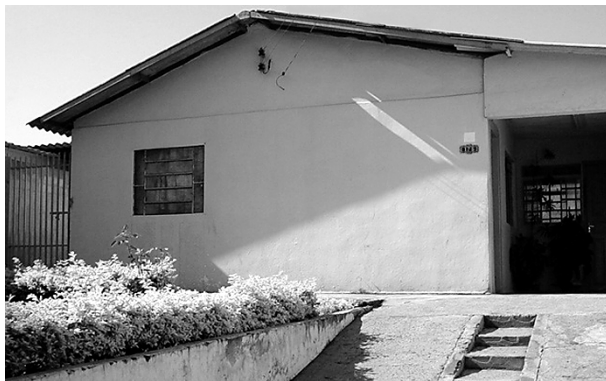
Figura 1 – Casa de alvenaria tradicional (fachada sul)
