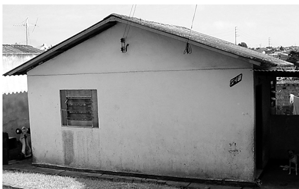
Figura 3 – Casa de concreto (fachada sul)
