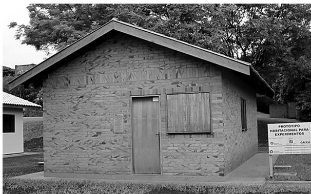
Figura 4 – Protótipo em blocos cerâmicos, construído no Campus da UEL (fachada sul)
