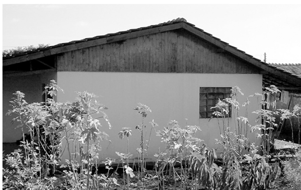
Figura 2 – Casa de fibrocimento (fachada sul)
