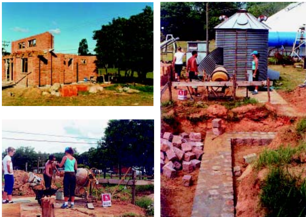
Figura 3 - Atividades de construção do protótipo habitacional no Campus da UFRGS
