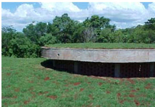
Figura 9 – Cobertura verde no recinto do “Sol e da Lua”, no Refúgio Biológico Bela Vista, em Foz do Iguaçu Foto cedida pela Central Hidrelétrica de Itaipu, 2002
