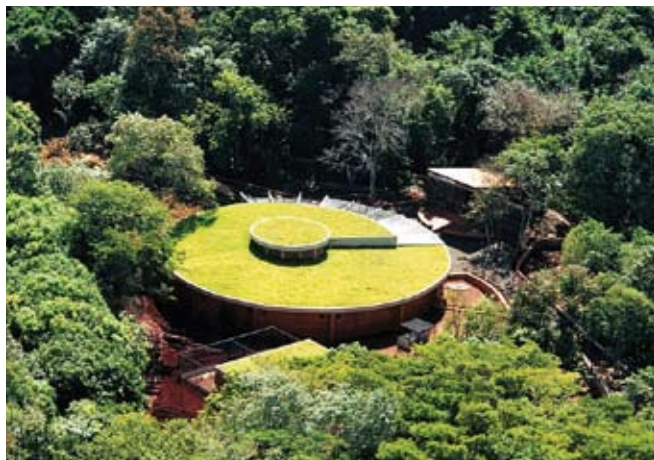
Figura 4 – Uma das edificações identificadas com o elemento TERRA, presente em sua cobertura, construída para o Refúgio Biológico Bela Vista, em Foz do Iguaçu (Sattler et al., 2003) Foto cedida pela Central Hidrelétrica de Itaipu, 2003.
