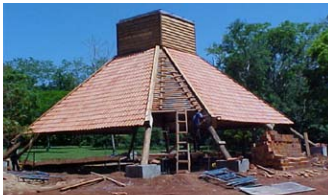
Figura 8 – A Choupana, no Refúgio Biológico Bela Vista (projetada para enfatizar a estratégia e as possibilidades de reúso de resíduos de construção) Foto do autor.
