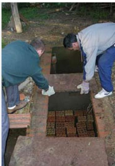
Figura 233 – Sistema modular, em construção, mostrando, à esquerda, os seus dois compartimentos (acima, digestor; abaixo, o filtro). À direita, o sistema modular sendo coberto por laje, onde também se observa o filtro (abaixo), executado com o uso de blocos de 6 furos
