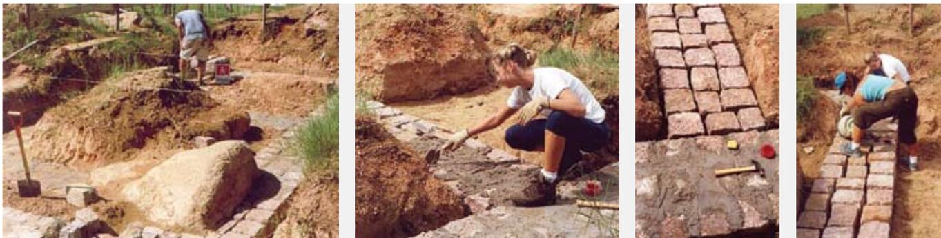
Figura 213 – Construção dos alicerces sobre o berço, em 02/03/02
