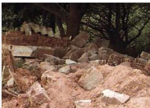
Figura 211 – Materiais reusados para as fundações (à esquerda, materiais descartados na substituição de pavimentos do *campus* Central da UFRGS: à direita, restos de demolição de construção preexistente ao lado do lote destinado ao protótipo), em 02/01/02
