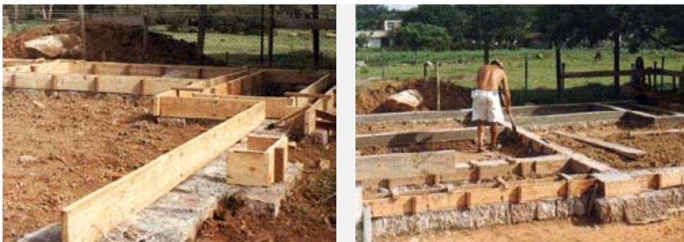
Figura 214 – Execução das formas para as vigas de fundação, em 20/03/02
