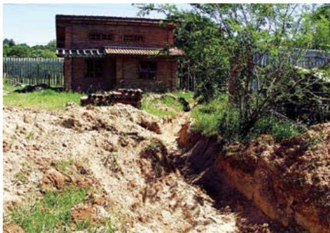
Figura 228 – Implantação do sistema de tratamento de águas residuárias do protótipo Casa Alvorada (vista a partir do leito de evapotranspiração, em execução)
