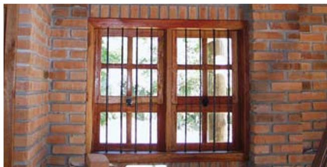
Figura 325 - Grade na janela da sala/cozinha
