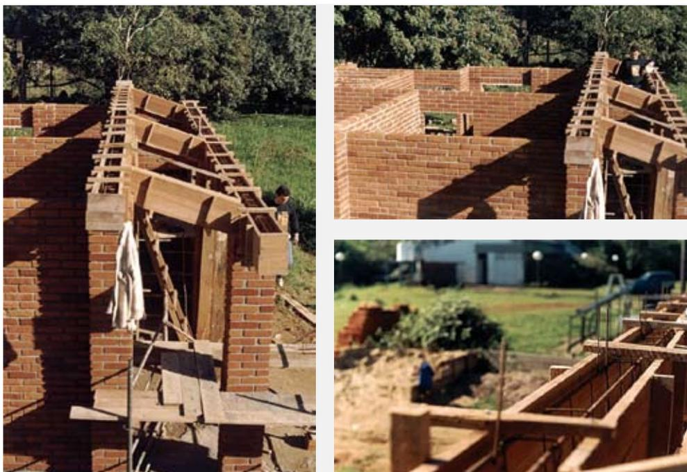
Figura 218 – Vigas de coroamento (telhado sul, inferior), em 14/06/02
